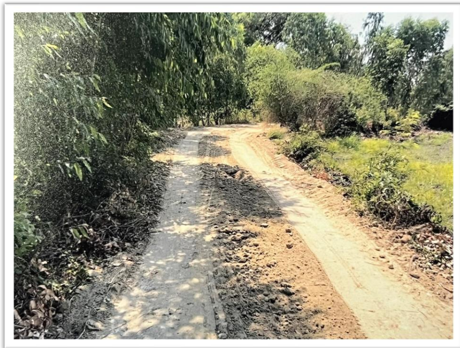
๑๒ โครงการซ่อมแซมถนนดินลูกรัง หมู่ที่ ๔ บริเวณไร่นายวิเชียร น้อยประถม ถึงเขตตำบลดงพลับ
