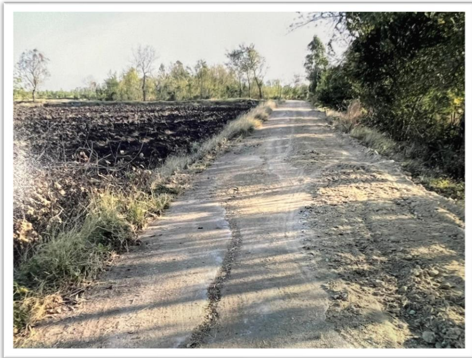
๗. โครงการซ่อมแซมถนน ค.ส.ล. หมู่ที่ ๒ บริเวณวัดท่าฉนวน ไปถึงถนน รพช. เส้นถลุงเหล็ก - หนองไผ่
