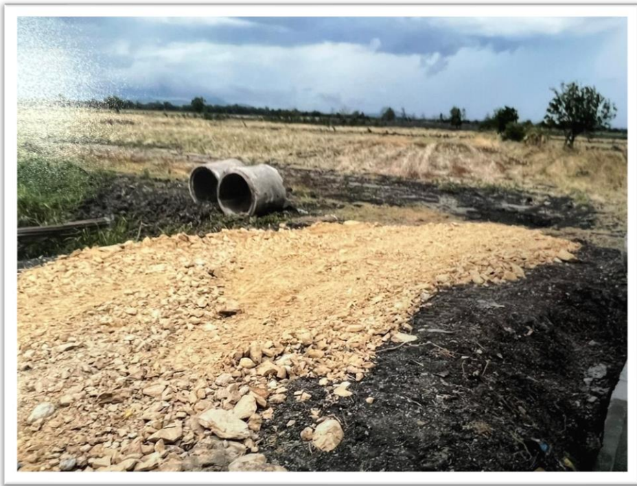
๓. โครงการซ่อมแซมท่อระบายน้ำ หมู่ที่ ๒ จุดที่ ๑ บริเวณนายนายเสมอ ทองสุภาพ
