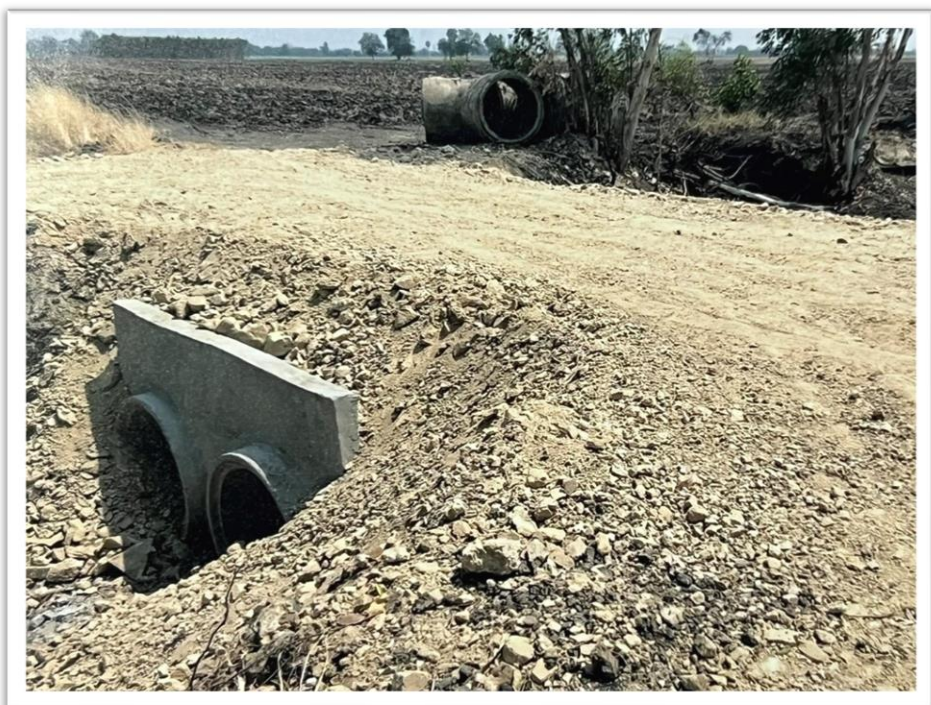
๑๖. โครงการซ่อมแซมถนนดินลูกรังและท่อระบายน้ำ ทางข้ามบริเวณที่นา นายบุญมา เงินดี หมู่ที่ ๖
