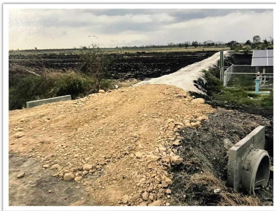
๔. โครงการซ่อมแซมท่อระบายน้ำ หมู่ที่ ๒ จุดที่ ๒ บริเวณนายนายเสมอ ทองสุภาพ
