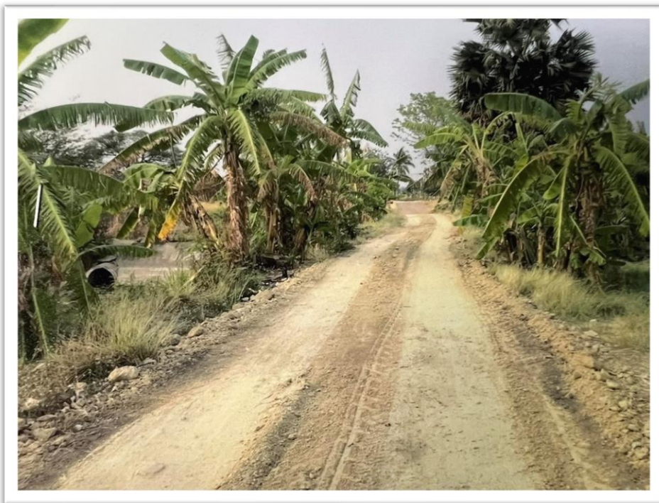
๒๖. โครงการซ่อมแซมถนนดินลูกรัง หมู่ที่ ๗ บริเวณถนน รพช. ไปถึง นานายแป๊ะ ทาทั่ว
