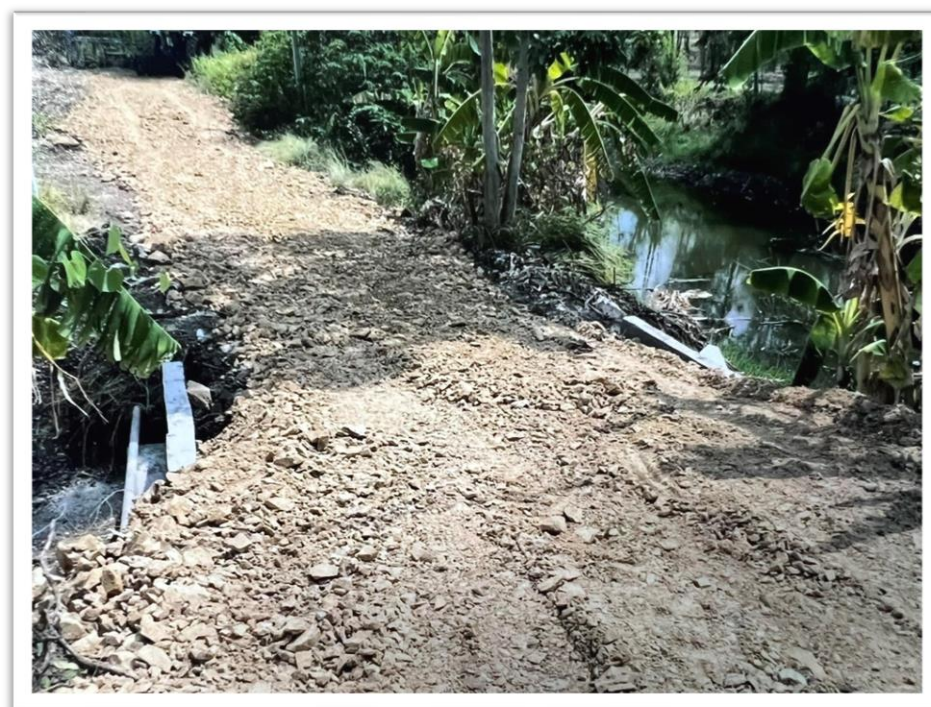
๒๔. โครงการซ่อมแซมท่อระบายน้ำ หมู่ที่ ๗ บริเวณทางเข้าประปาหมู่บ้าน
