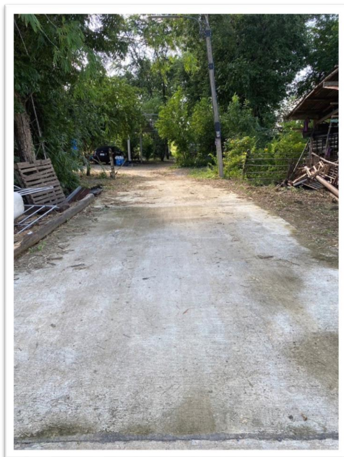
๓. โครงการก่อสร้างถนน ค.ส.ล. หมู่ที่ ๕ เส้นที่ ๒
