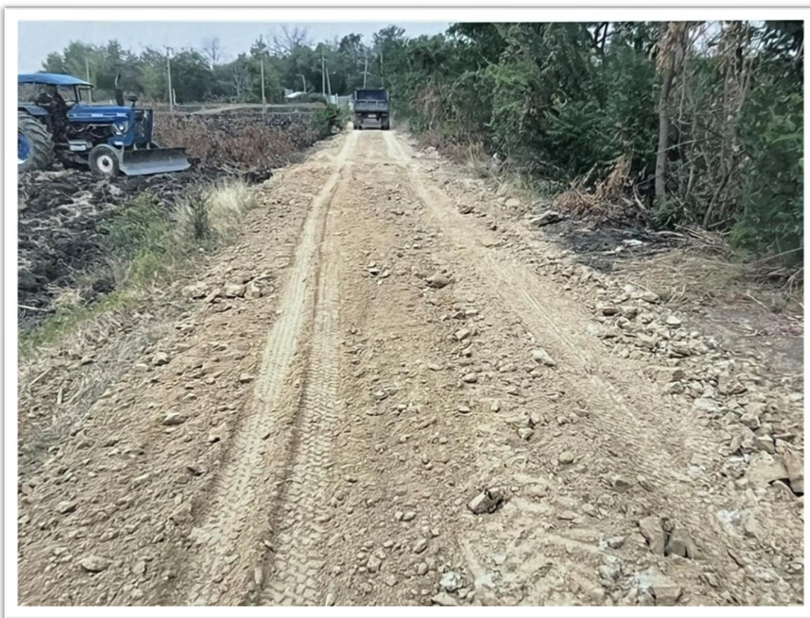
๖. โครงการก่อสร้างถนนลูกรัง หมู่ที่ ๑
