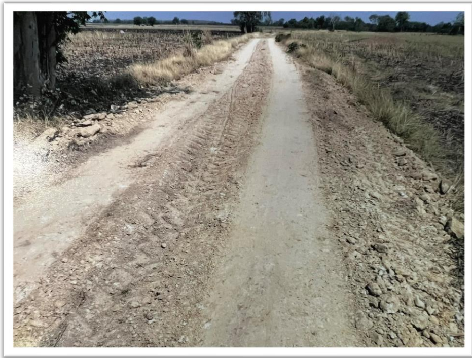
๙. โครงการซ่อมแซมถนนดินลูกรัง หมู่ที่ ๔ บริเวณถนน ค.ส.ล.ไปถึงไร่ นางบัวทอง โสพรม
