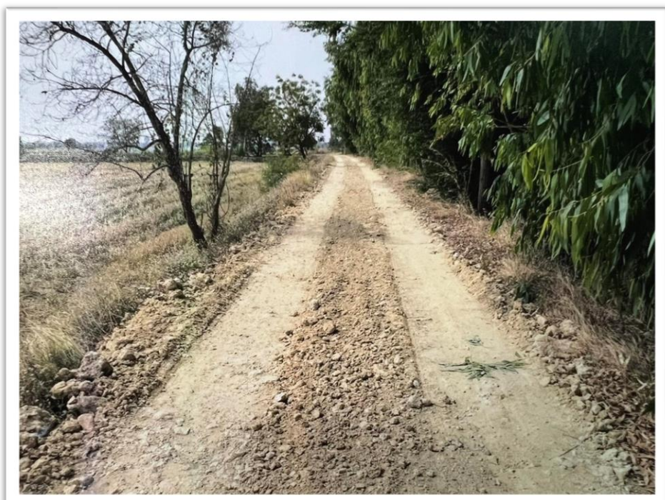
๖. โครงการซ่อมแซมถนนดินลูกรัง หมู่ที่ ๒ จากนายเสมทองสุภาพ ไปถึงนายบุญมา เงินดี
