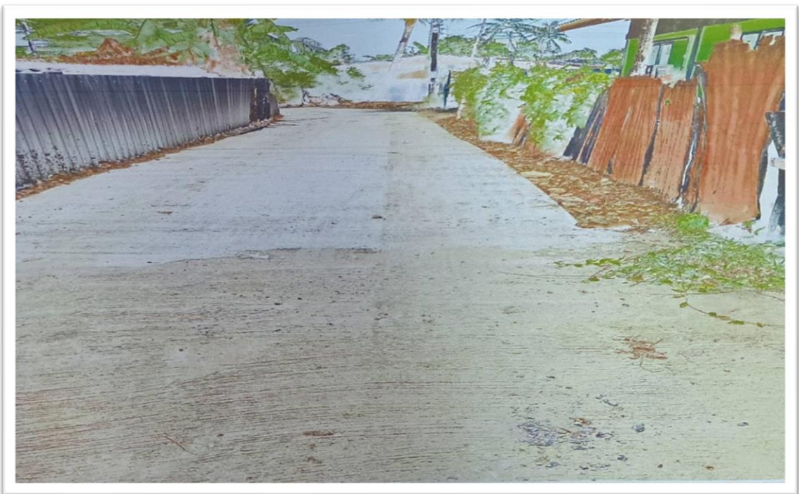
๕. โครงการก่อสร้างถนน ค.ส.ล. หมู่ที่ ๖ เส้นที่ ๒
