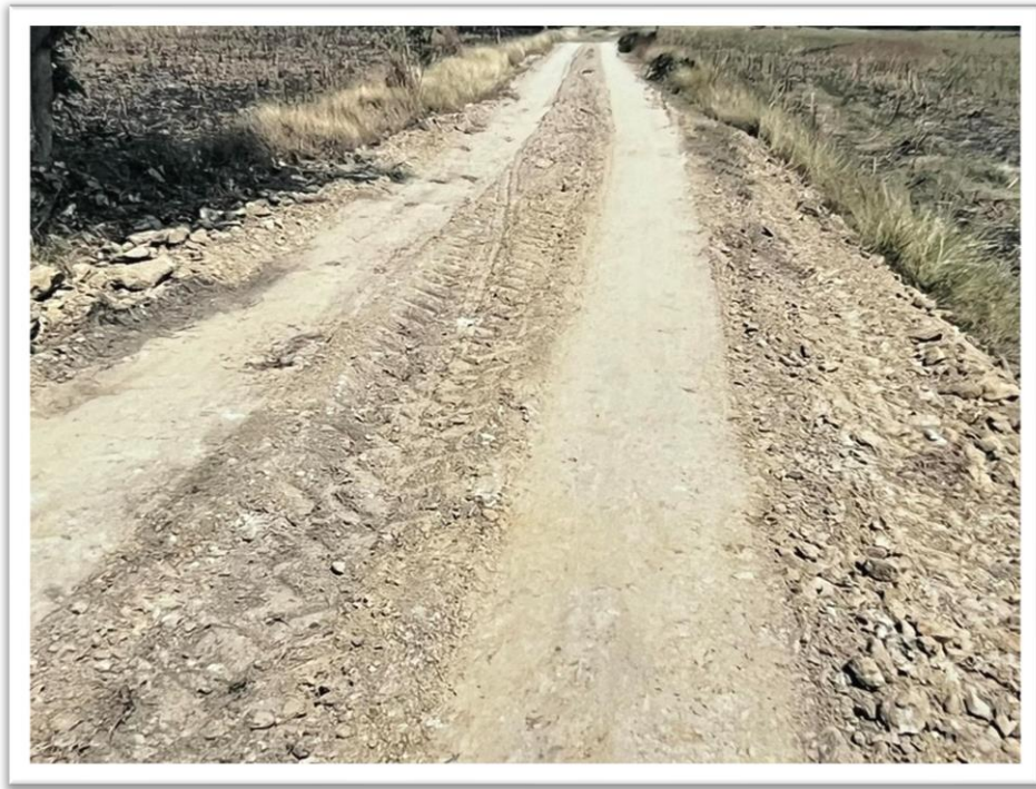
๒๕. โครงการซ่อมแซมถนนดินลูกรัง หมู่ที่ ๗ บริเวณหน้าฟาร์มไก่ ไปถึงอ่างเก็บน้ำ หมู่ที่ ๒
