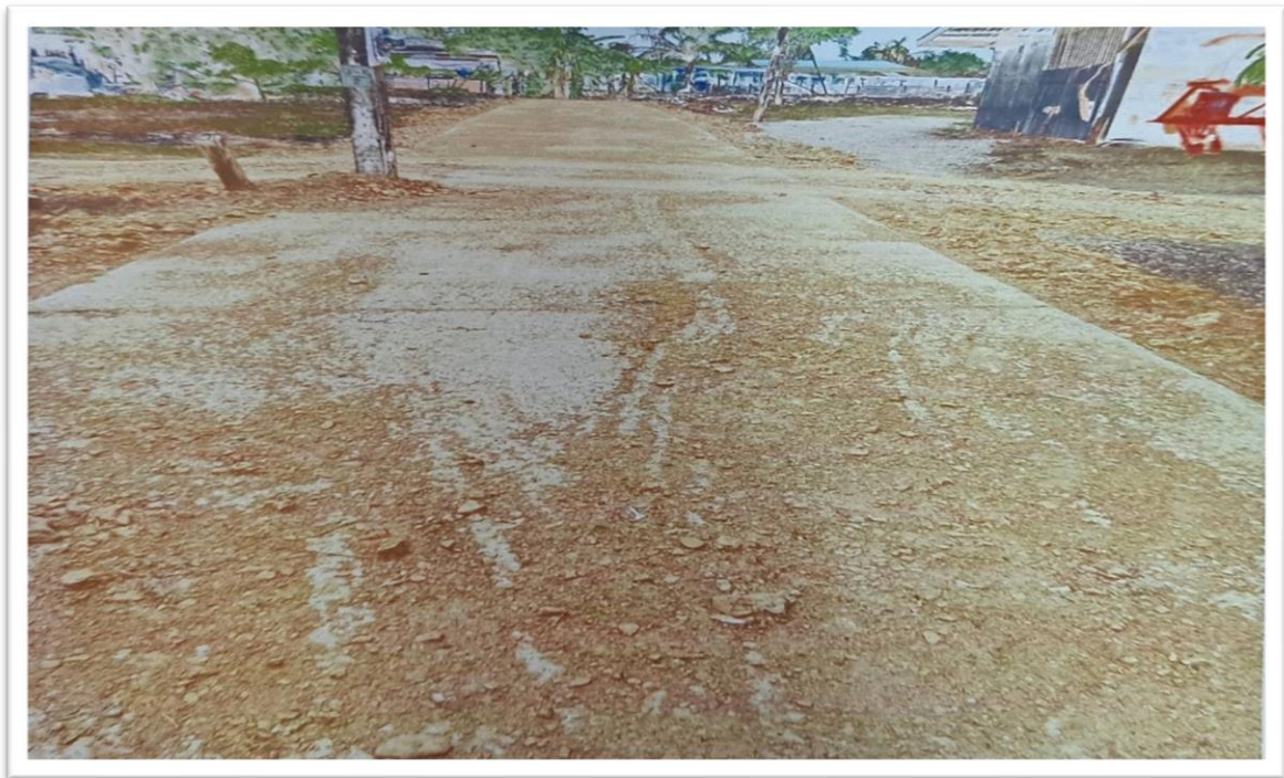
๔. โครงการก่อสร้างถนน ค.ส.ล. หมู่ที่ ๖ เส้นที่ ๑
