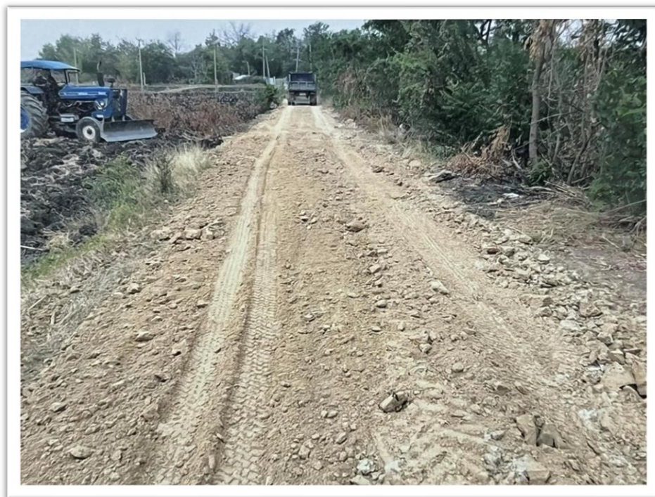
โครงการก่อสร้างถนนลูกรัง หมู่ที่ ๑
