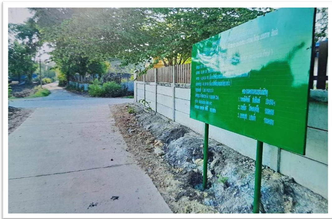
๒. โครงการก่อสร้างถนน ค.ส.ล. หมู่ที่ ๕ เส้นที่ ๑
