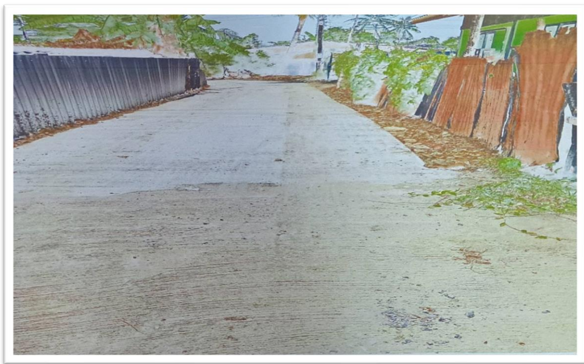
๖. โครงการก่อสร้างถนน ค.ส.ล. หมู่ที่ ๖ เส้นที่ ๒
