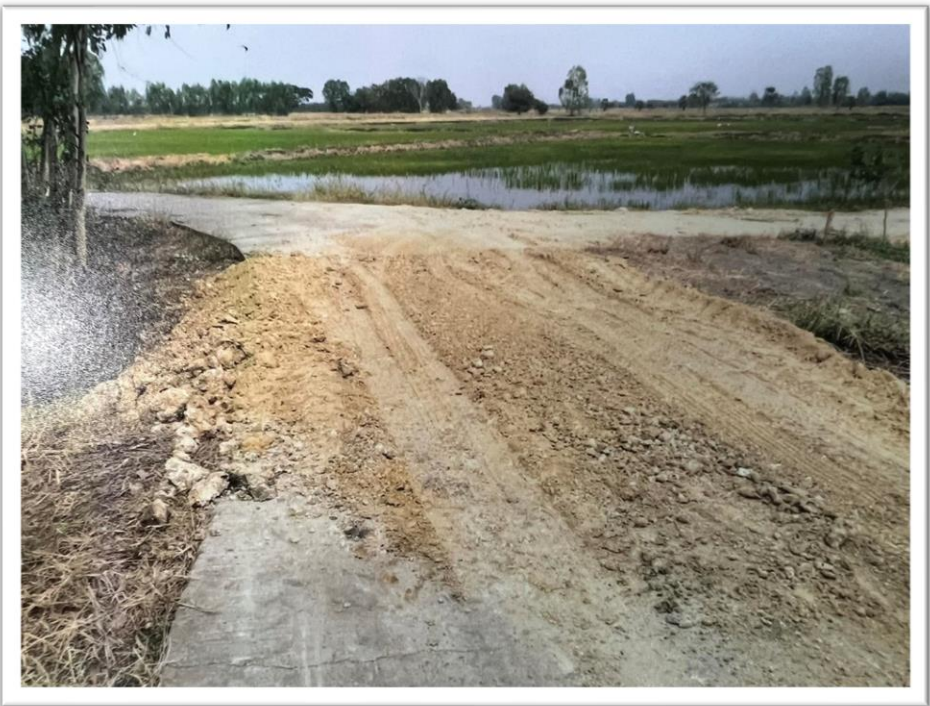
๘. โครงการซ่อมแซมถนนดินลูกรัง บริเวณถนน ค.ส.ล. หมู่ที่ ๓ ถึง ถนน ค.ส.ล. หมู่ที่ ๖
