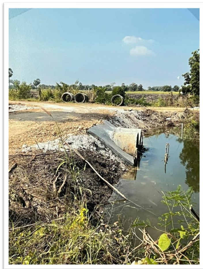
๒๐. โครงการซ่อมแซมท่อระบายน้ำ หมู่ที่ ๖ บริเวณที่นายนางกุหลาบ แก้วสง่า
