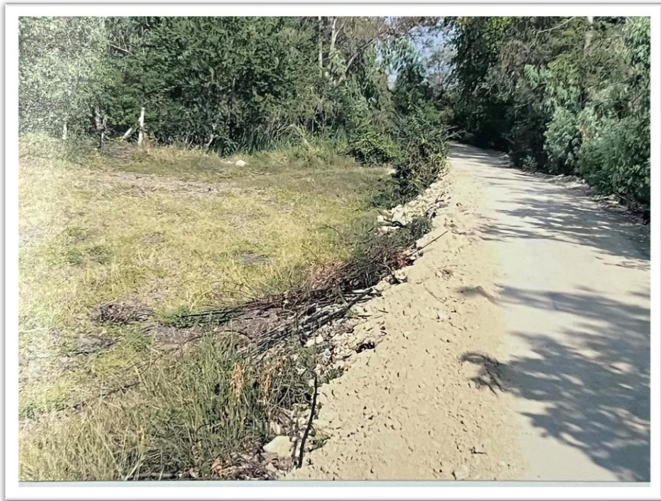
๑๕. โครงการซ่อมแซมถนนดินลูกรัง หมู่ที่ ๕ บริเวณนางสาวสังวาล น้อยประถม ถึงฝายน้ำล้น
