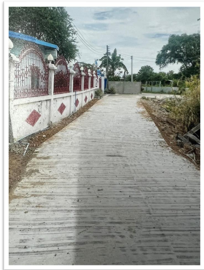
๑๑.โครงการซ่อมแซมถนน ค.ส.ล. หมู่ที่ ๔ บริเวณทางเข้าบ้าน นางบัวทอง ลาภมีเสมอ
