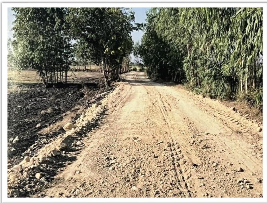
๑๙. โครงการซ่อมแซมถนนดินลูกรัง หมู่ที่ ๖ บริเวณที่นายนายสมปอง แสนโคตร ถึงบริเวณฝายน้ำล้นที่นา นายทองพูล โสพรรณ
