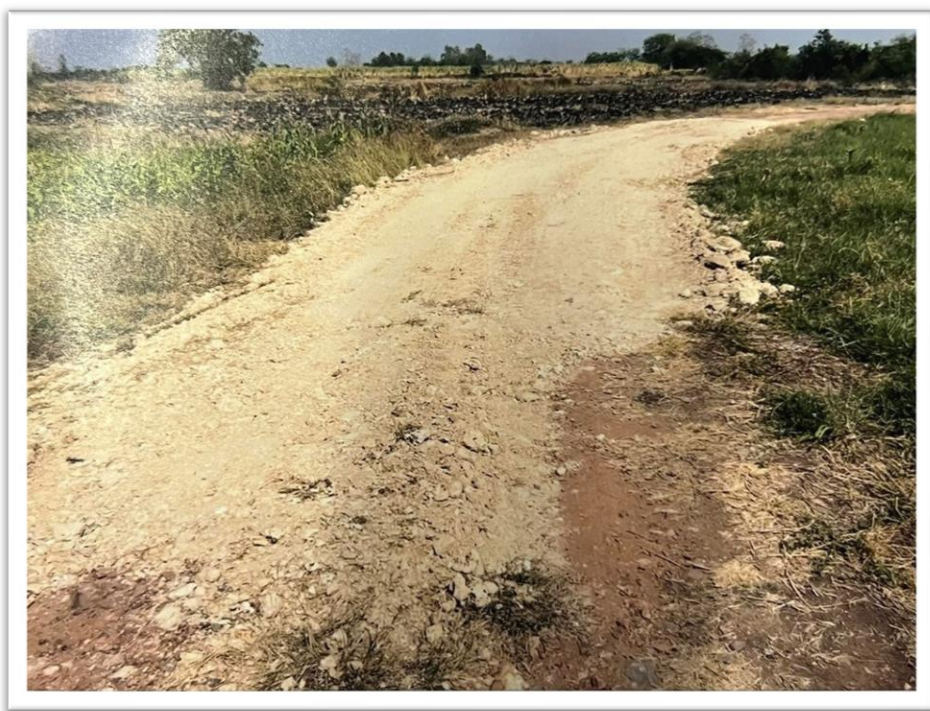
๑๐.โครงการซ่อมแซมถนนดินลูกรัง หมู่ที่ ๔ บริเวณถนน ค.ส.ล. ถึงฝายดงพลับ
