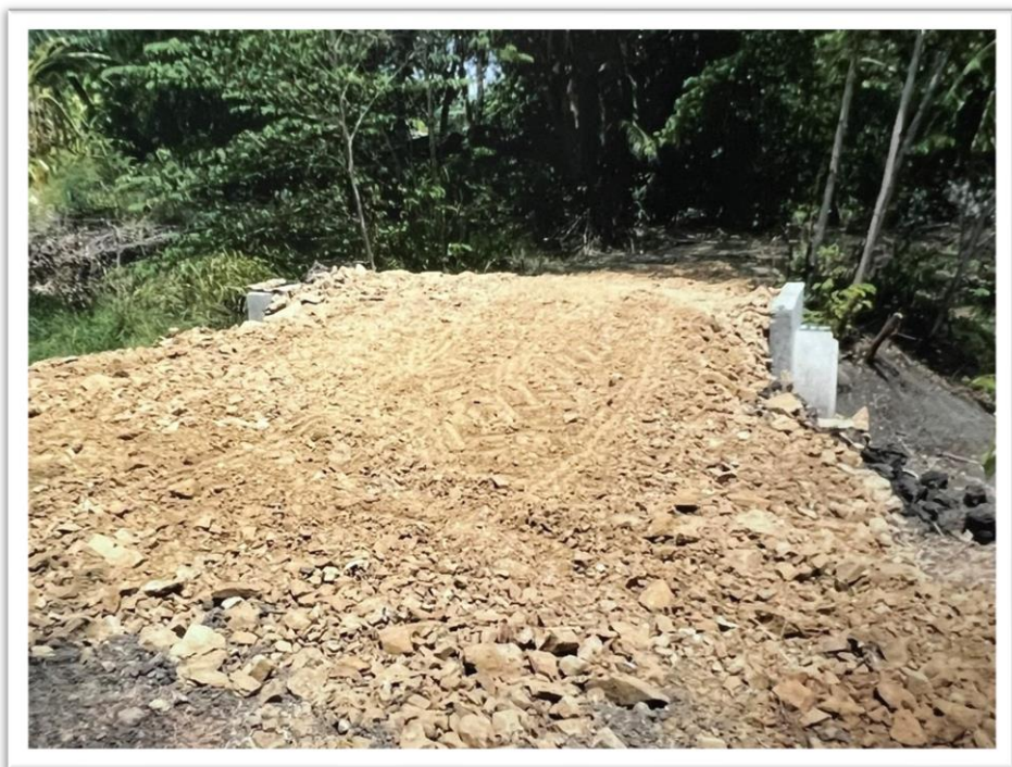
๒๓. โครงการซ่อมแซมวางท่อระบายน้ำ หมู่ที่ ๗ บริเวณนางางดวงเดือน บุญฤทธิ์
