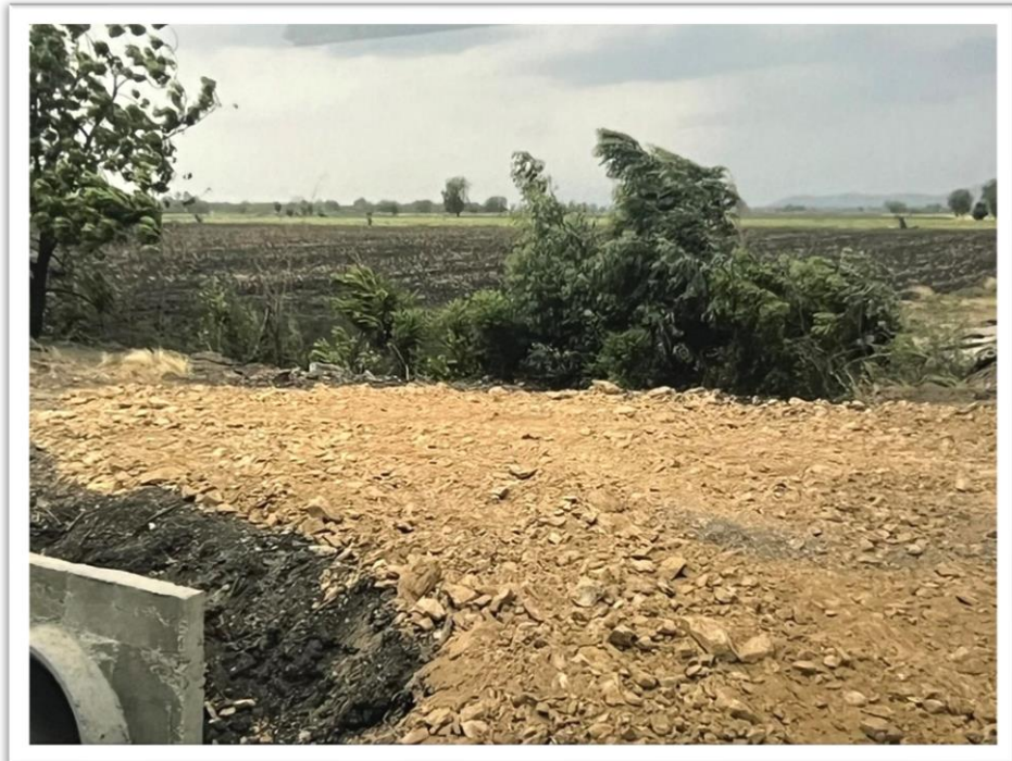
๕. โครงการซ่อมแซมท่อระบายน้ำ หมู่ที่ ๒ จุดที่ ๓ บริเวณนายคำพิ ทำทัน
